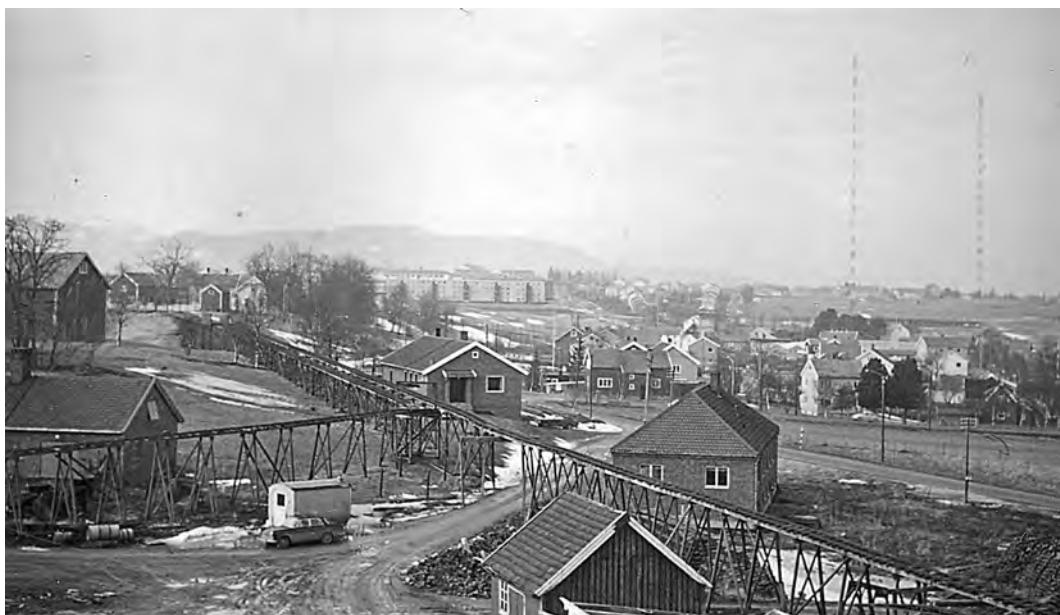
Utsikt vestover i 1963. Til høyre for kabelbanen ligger velferdsbygget “Stjerna” (nærmest) og kontorbygget. Midt på bildet foran er gammelsmia. Bak til venstre ser vi låven på Søndre Reitgjerdet og i bakgrunnen Buchhaugen. Foto: Melvin Johansen.
