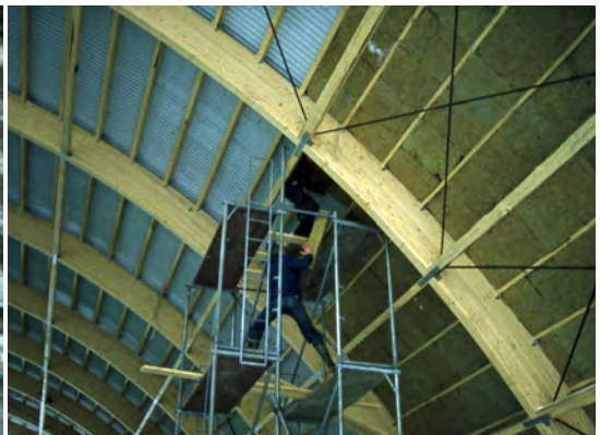
Hallen reiser seg i 1978. Til venstre: En luftig arbeidsplass og dugnadsfolk uten høgdeskrekk. Til høyre: Store mengder Rockwool isolasjon skal på plass. Foto: Nils Dahl.
