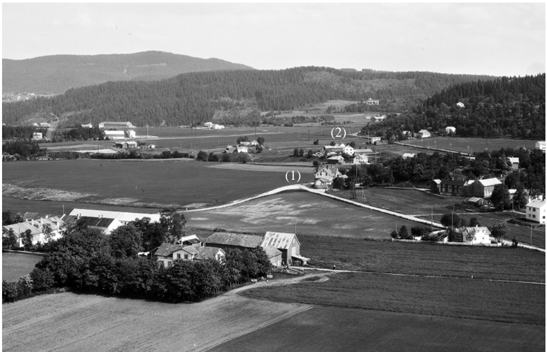
Jonsvannsveien med Ramstadkrysset (1) og Blekkankrysset (2). I forgrunnen Åsheim gård - nå helt utbygd med boliger. Området med bygninger til venstre for Åsheim var militært område, nå også det med boliger. Foto: Telemark Flyselskap, 1958. Kopi fra www.flyfotoarkivet.no .
