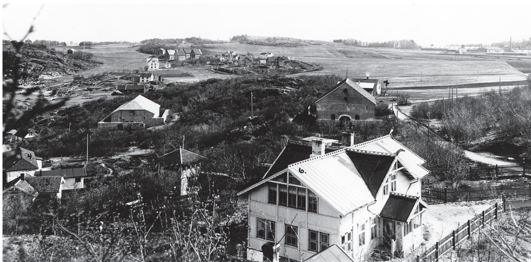
Utsikt fra Ladehammeren i retning Korsvika i mai 1923. Karlsheim i forgrunnen. Ned til venstre er vokterboligen for krutthusene. Bak Karlsheim ser vi de to krutthusene. Rett over krutthuset til venstre ser vi småbruket Tronstad og taket på Haugan (Isaksen). Bak krutthuset til høyre er John og Agnete Aunes småbruk. Foto: Schröder. Fra Trondheim byarkiv - fra www.flickr.com .
