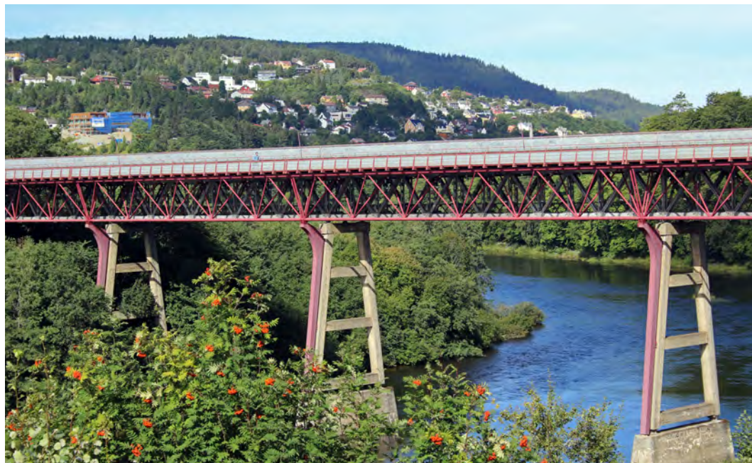
Dagens bru: Stavnebrua slik den fremstår i dag, 186 meter lang og med en tre meter bred gangbane. På vestsiden er sporene på Dovrebanen nordfra og sørfra koblet sammen like ved brua.
