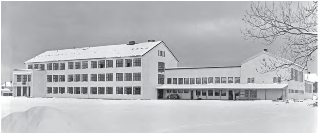
Strinda realskole og gymnas under bygging 22. februar 1955, innviet 16. april 1956.
