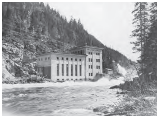
Løkaunet kraftstasjon ved Hyttefossen i Klæbu rundt 1933. Foto: Schrøderarkivet - Sverresborg Trøndelag folkemuseum.
