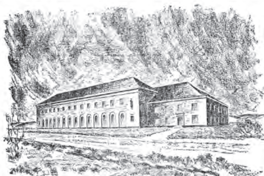
Moholt transformatorstasjon, hvor linjen ender. (tegning av arkitekt Th. Brekke.)
