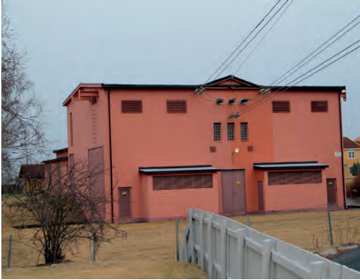
Trafostasjon bygget på Belbuan av FKK ca. 1927. Foto: Jan Habberstad. Fra WikiStrinda.
