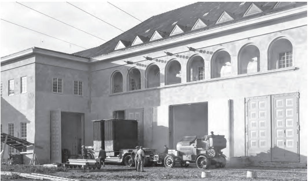
Gigant passerer Singsaker skole på det øverste bildet og er framme ved Moholt trafostasjon på det nederste 17. september 1925. Foto: Statkraft Trondheim.
