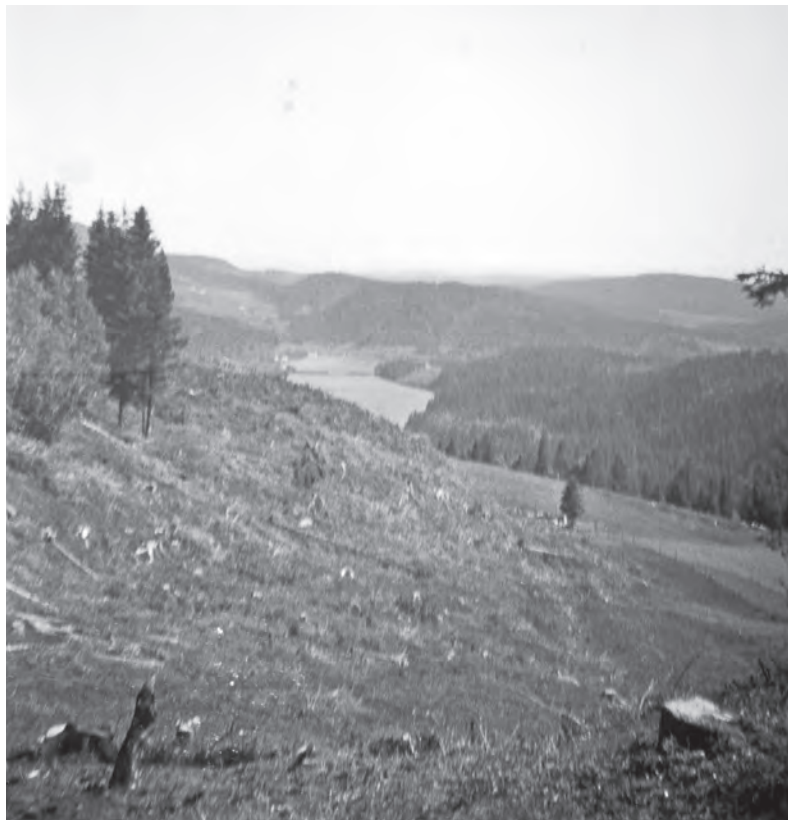
Utsikten fra hytte- eiendommen Granly østover mot Litjvatnet. Bildet er tatt i 1945. Utlånt av Svein E. Johansen.
