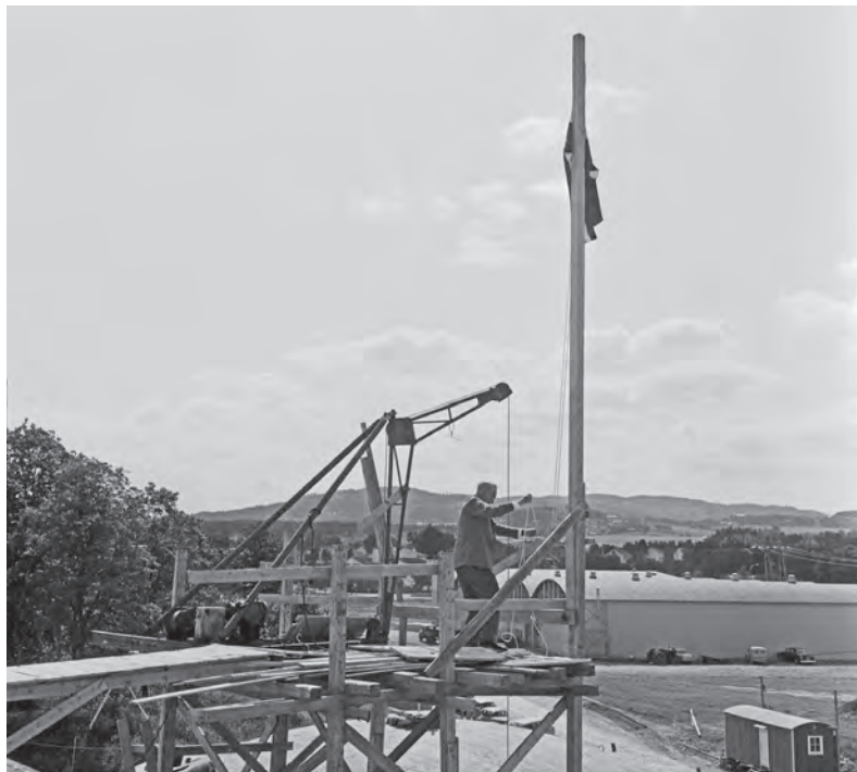
Bilde i Adresseavisen 15. juli 1961. Under bildet står det: «Formannen i styret for KØFF Engros A/S Nord, kjøpmann G. Garmo, heiser flagget på mønsåsdagen ved kjempebygget». I bakgrunnen sees buetakene på FIGROs bygg. Foto: Schrøder-samlingen/ Sverresborg Trøndelag Folkemuseum.
