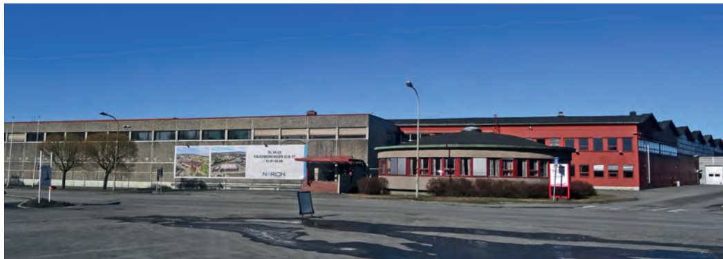
KØFF-bygget i april 2016. KØFF og FIGRO fusjonerte i 1986. I 2016 var begge byggene til salgs samlet. Det var en stor salgsplakat på bygget. KØFF-bygget er blitt utvidet etter 1962. Foto: Knut L. Vik.
